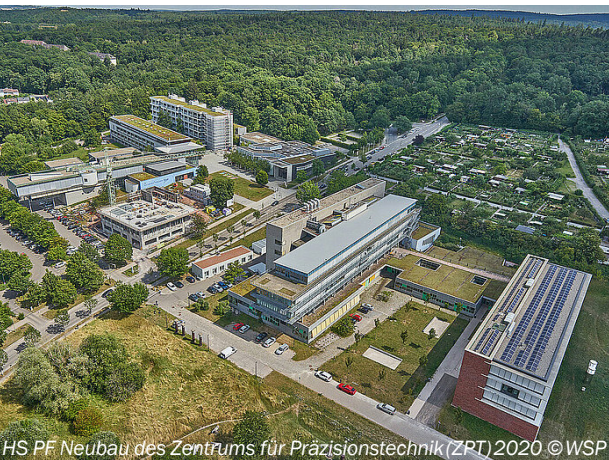
HS PF Neubau des Zentrums für Präzisionstechnik (ZPT) 2020 © WSP
